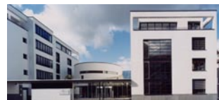
Fassade zur Danneckerstraße
